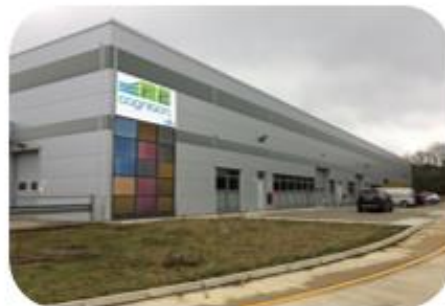
Sistem Fotovoltaic integrat în anvelopa clădirii
