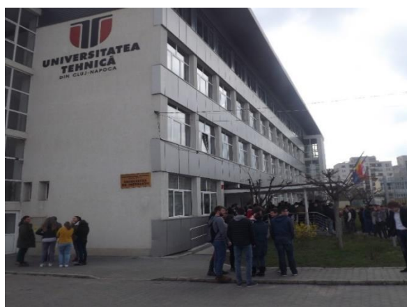
Facultatea de Instalații
